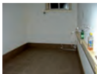
neue Fliesen im Büro.
