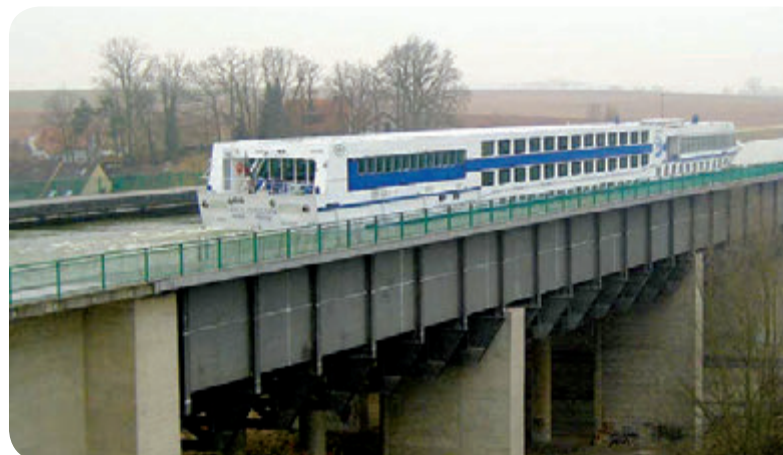
Wasserbrücke bei Fürth-Nürnberg.
