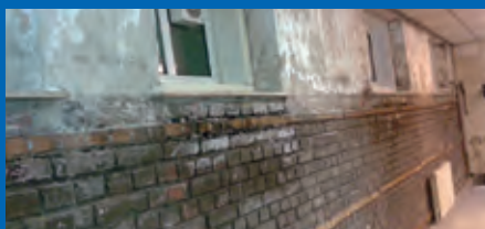
Während der Renovierung.
