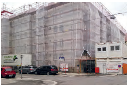
Wohnhausblock als Baustelle
